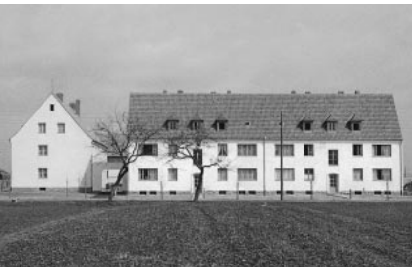
Steinheim, Billerbeckerstr., Rückansicht.
